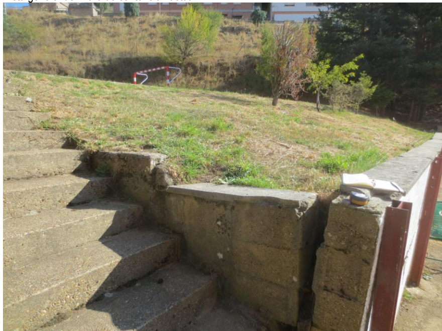
Una vista en detalle de la cabeza del muro
