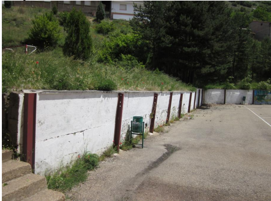
Vista general del muro de contención actual
